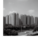
成都中海城南2号地项目
