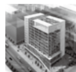
深圳市宝安区质检站办公楼
